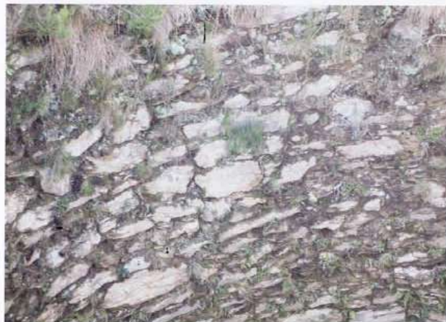
Figura 09. Mamposteria de pedra enmuros de neveira de Vilarinho-Fixó
